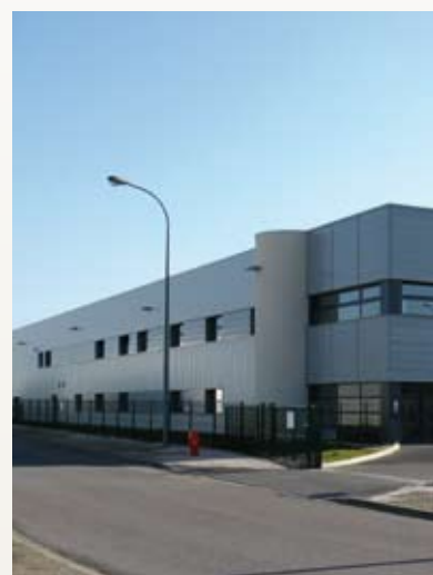
Stabilimento principale e centro di riparazione CEAT Electronique a Longvic, Francia
