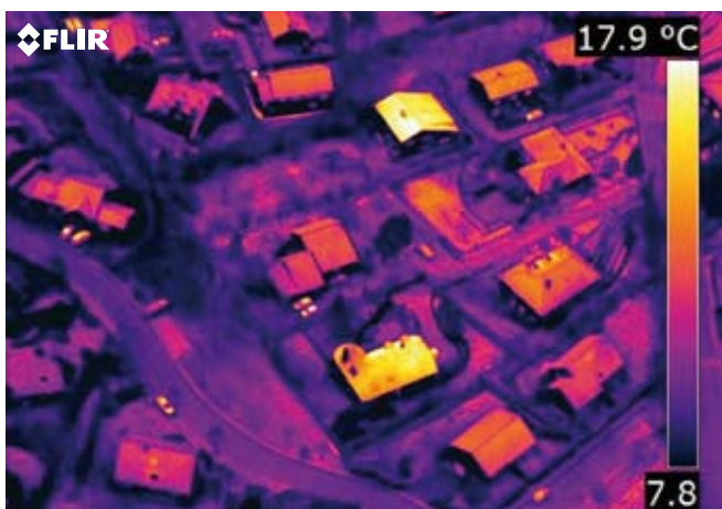
Gli edifici con i tetti di colore giallo mostrano che c'è un problema di umidità o di isolamento.
