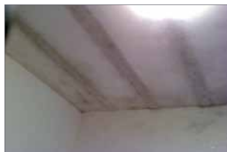
Queste immagini mostrano chiaramente che i punti freddi causati dai ponti termici coincidono esattamente con la comparsa di muffa.
